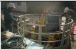
架台搬入状況
